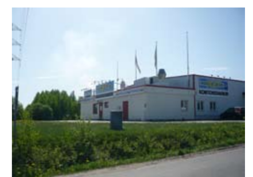
Exempel på byggnad av mycket gott skick.
